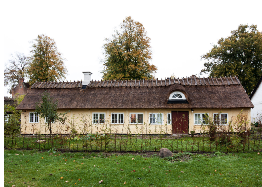
Kålundshuset, Kålundsvej 29 - renovering
