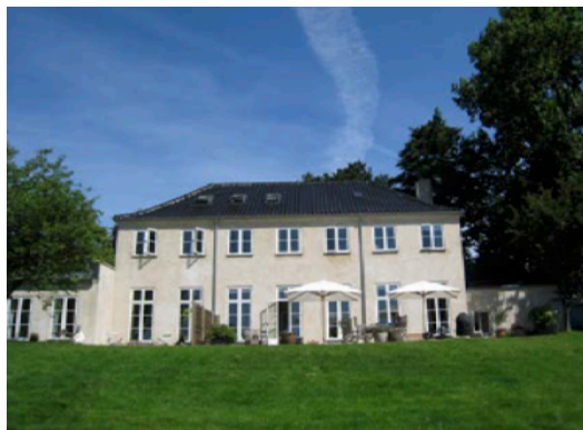
Søvej 4, Farum - tag og facaderenovering
